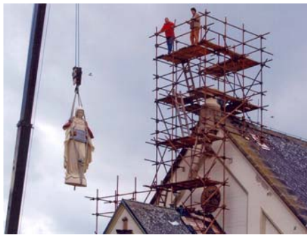
Die denkmalgeschützte Statue wird nach der Restauration auf ihren Sockel gehoben.
